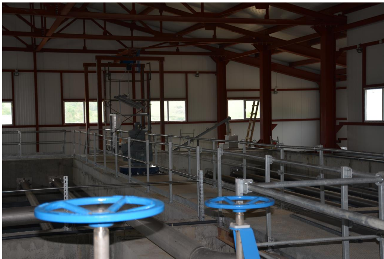
Новоизградено стъпало в технологичната схема - Ламелен утаител
