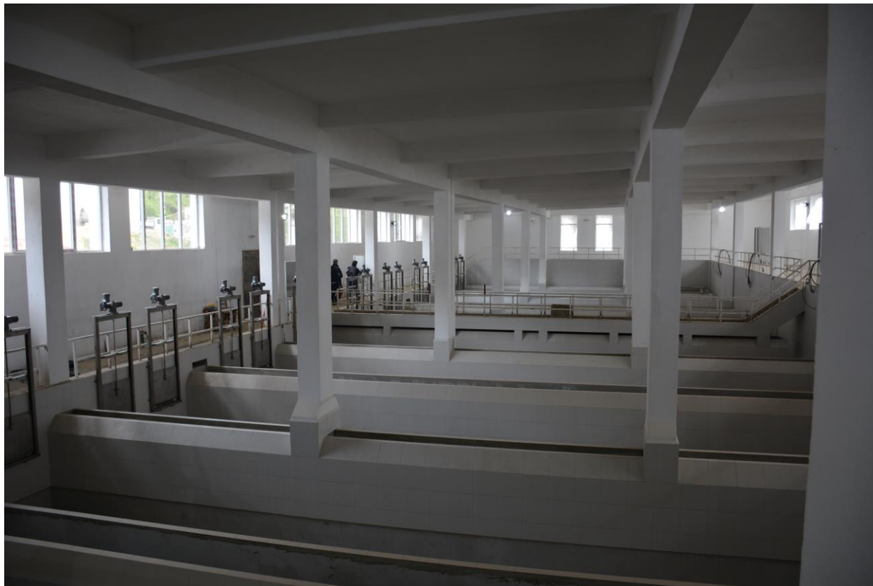
Реконструиран Филтърен корпус
